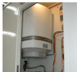
Chaudière électrique
