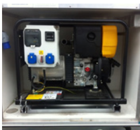
Groupe électrogène
